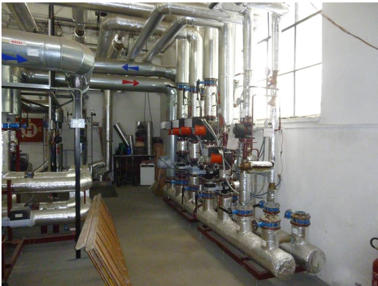
Foto č. 9 Areál vozovny autobusů a tramvají – PS1 rozdělovač
