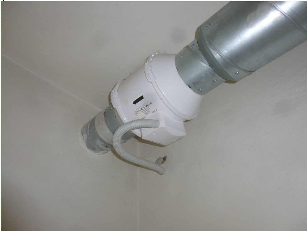
Foto č.12 Areál vozovny autobusů a tramvají – podtlakové větrání v šatnách
