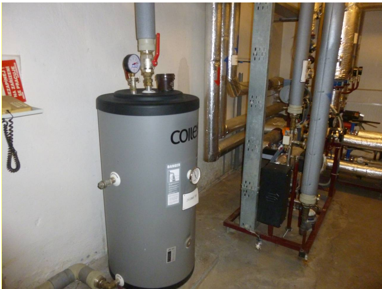
Foto č. 10 Areál vozovny autobusů a tramvají – zásobník TV
